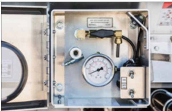
Figure 32 – Robinet de décharge d'air avec manomètre
